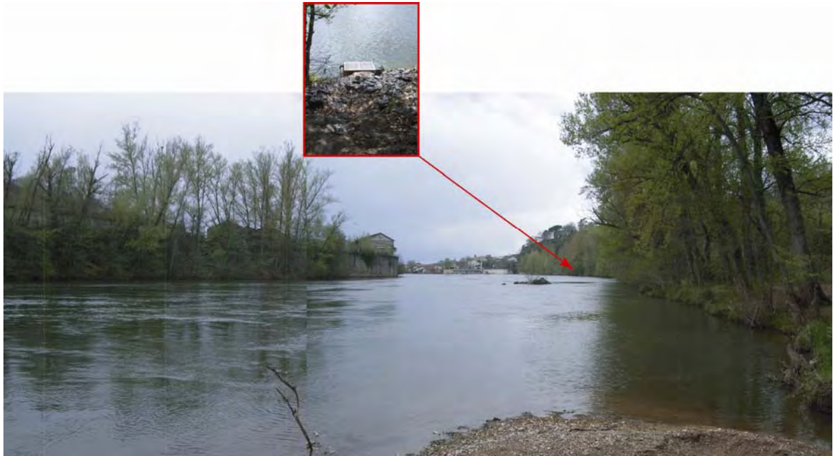
Fig. 11. Prise d'eau sur le Tarn, à Arthès
